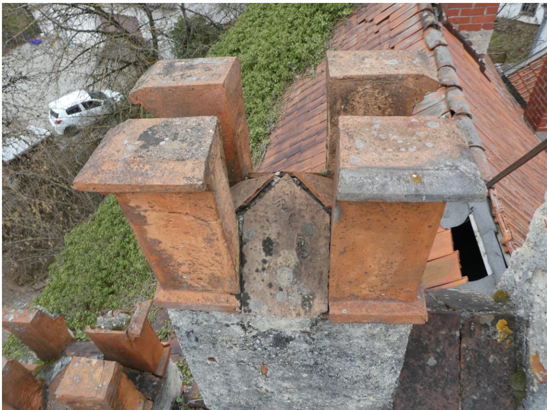
Formziegel der Zinnenaufsätze, der Zwischenraum wurde mit Ziegelplatten und Romankalkfuge abgedeckt, beides leider schadhafte bzw. locker
