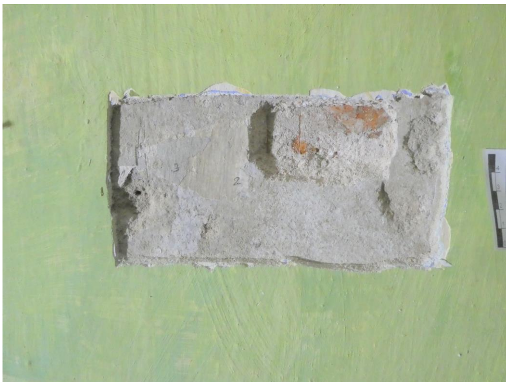
Historische Putzfläche, dünne Kalkputzlage mit 3 Kalkfassungen in gebrochenem Weiß bzw. Hellgrauer Tönung an der Außenwand nach Nordwesten, darüber Kalkputz aus dem 19. Jahrhundert mit Farbfassungen
