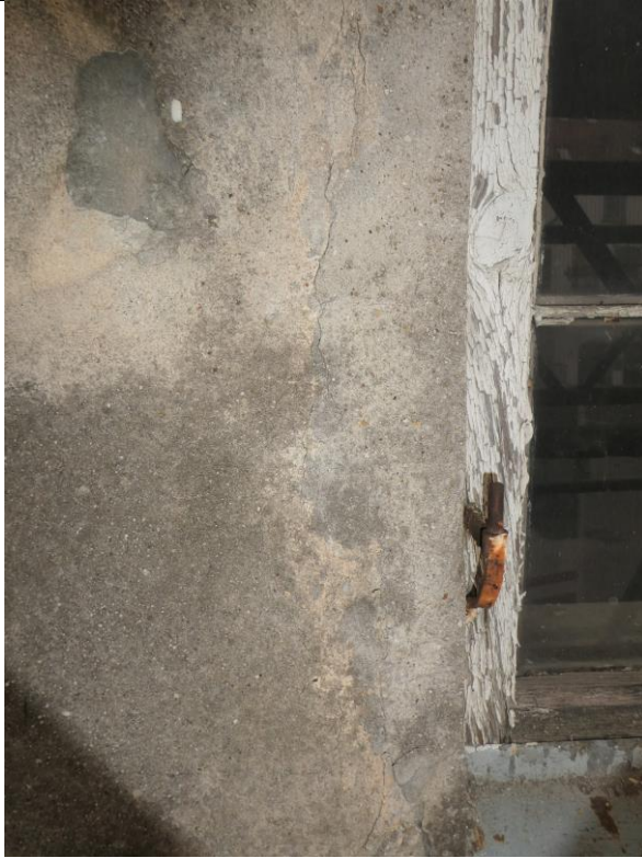
Putzergänzung um den Fensterrahmen Südwestfassade
