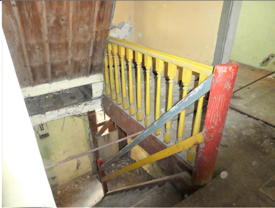
Treppenanlage vom Erdgeschoß zum Dachgeschoß, Treppenlauf und Geländer sind im 20. Jahrhundert erneuert worden, die Sprossenbrüstung hingegen ist aus dem 19. Jahrhundert erhalten geblieben.
