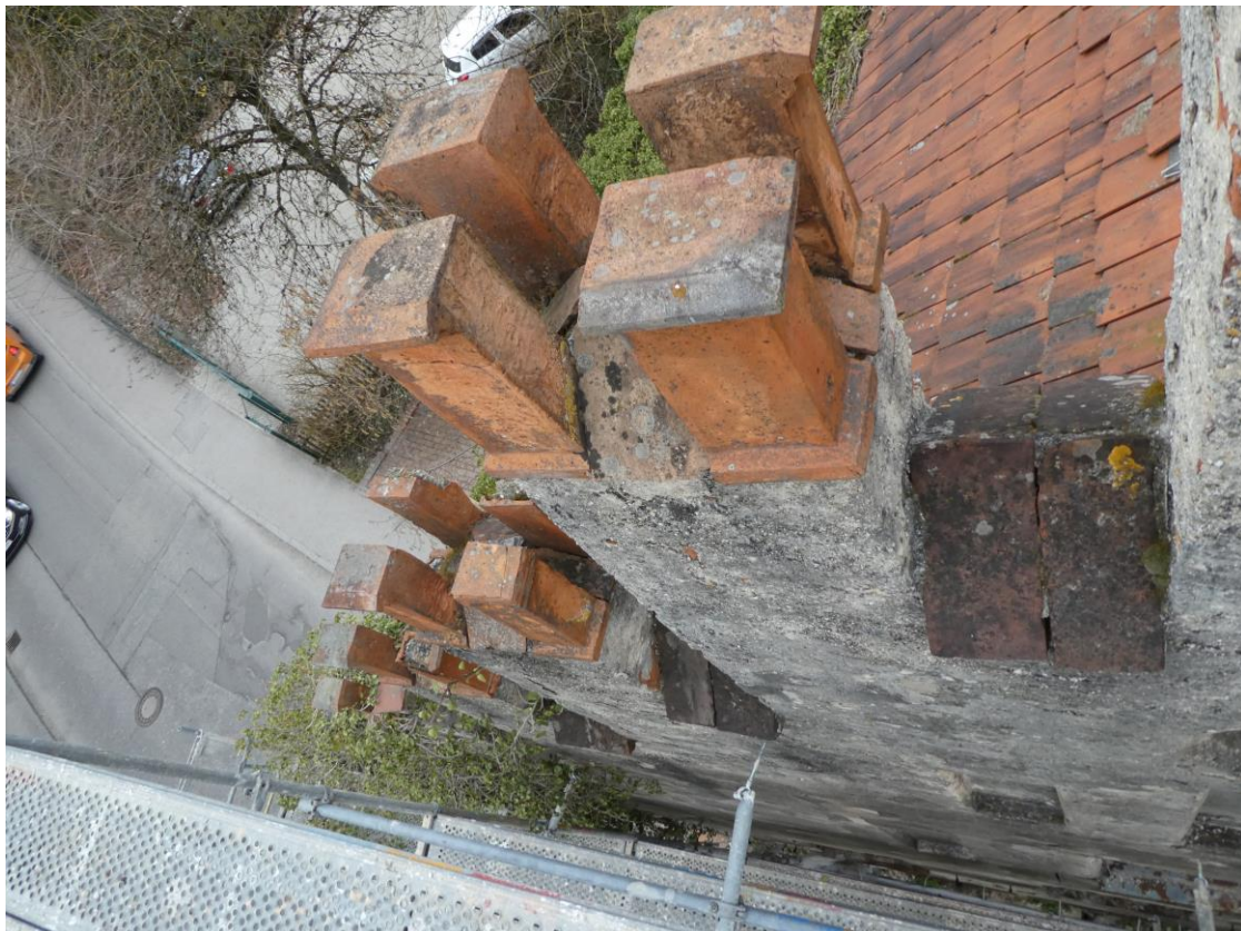
Zinnen am Südwestgiebel mit diversen Schadensbildern, die Vollziegelabplattungen zwischen den Zinnen sind relativ gut erhalten.
