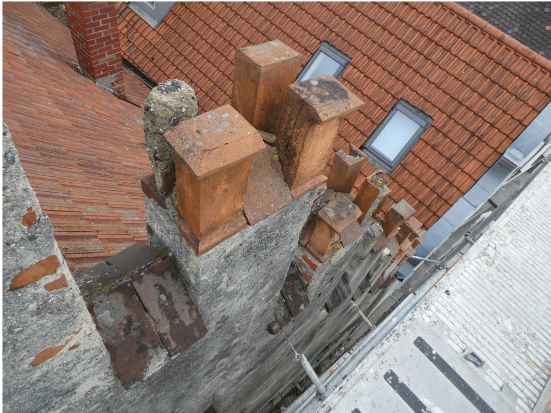
Zinnen am Südwestgiebel mit diversen Schadensbildern, die Vollziegelabplattungen zwischen den Zinnen sind relativ gut erhalten.
