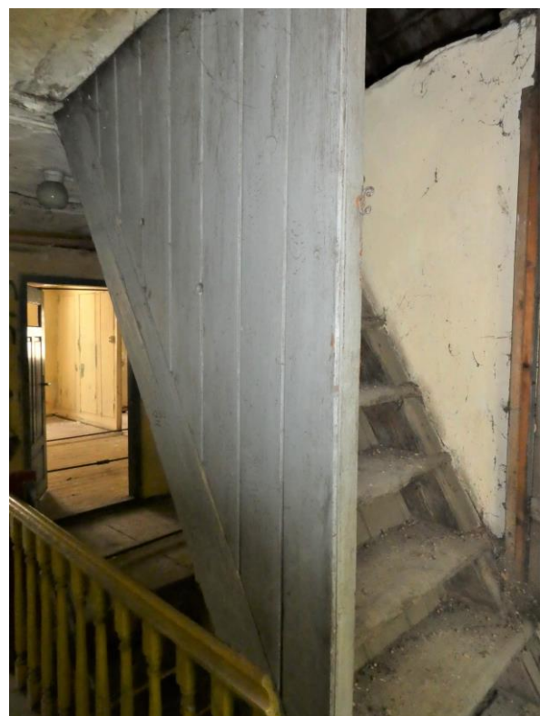
Treppe zum nicht ausgebauten Dachgeschoß, Holzverkleidung mit Türe, Erstfassung in grauer Ölfarbe, 19. Jahrhundert
