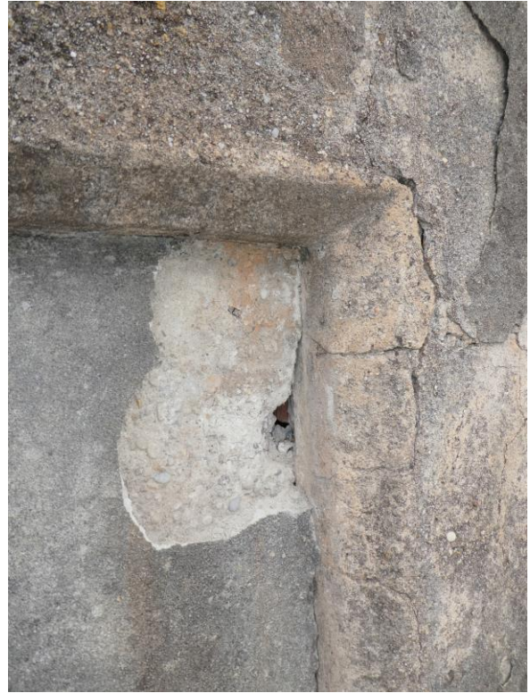
Zugesetztes Schlitzfenster am Giebel, Maßnahme um 1900 r
