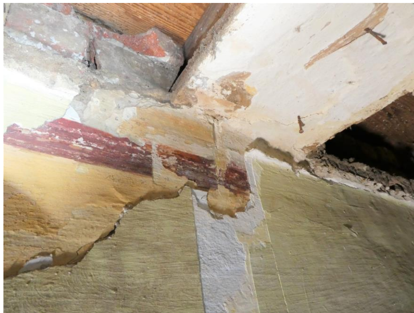
Decke Flur EG, Deckenbalken mit Brettunterbau, Relikt der Lehmschlagdecke, die zwischen den Deckenbalken ausgeführt war. Die Kalkanstriche wurden dann auf Lehmschlag und Holzflächen ausgeführt. Die ersten Farbfassungen aus dem 19. Jahrhundert sind noch an der Balkenunterseite nachweisbar, um 1900 wurde dann eine Rohrmattendecke darunter ausgeführt.
