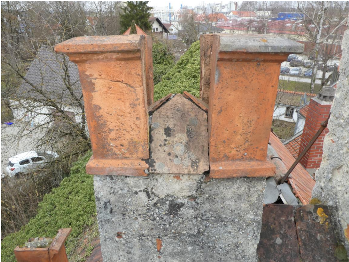
Formziegel der Zinnenaufsätze, der Zwischenraum wurde mit Ziegelplatten und Romankalkfuge abgedeckt, beides leider schadhafte bzw. locker
