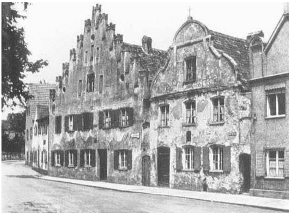
Aufnahme um 1955, starke Putzschäden bis zur Unterkante der Fenster im 1. OG erkennbar
