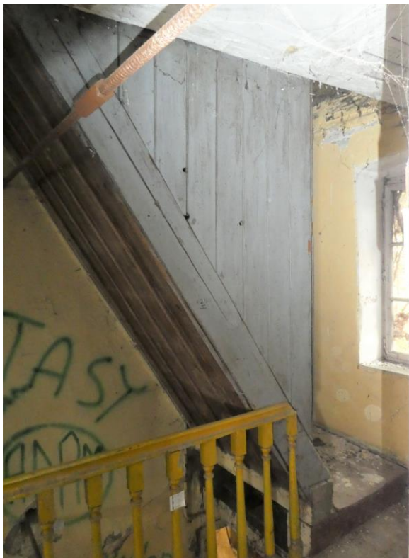
Treppe zum nicht ausgebauten Dachgeschoß, Holzverkleidung mit Türe, Erstfassung in grauer Ölfarbe, 19. Jahrhundert
