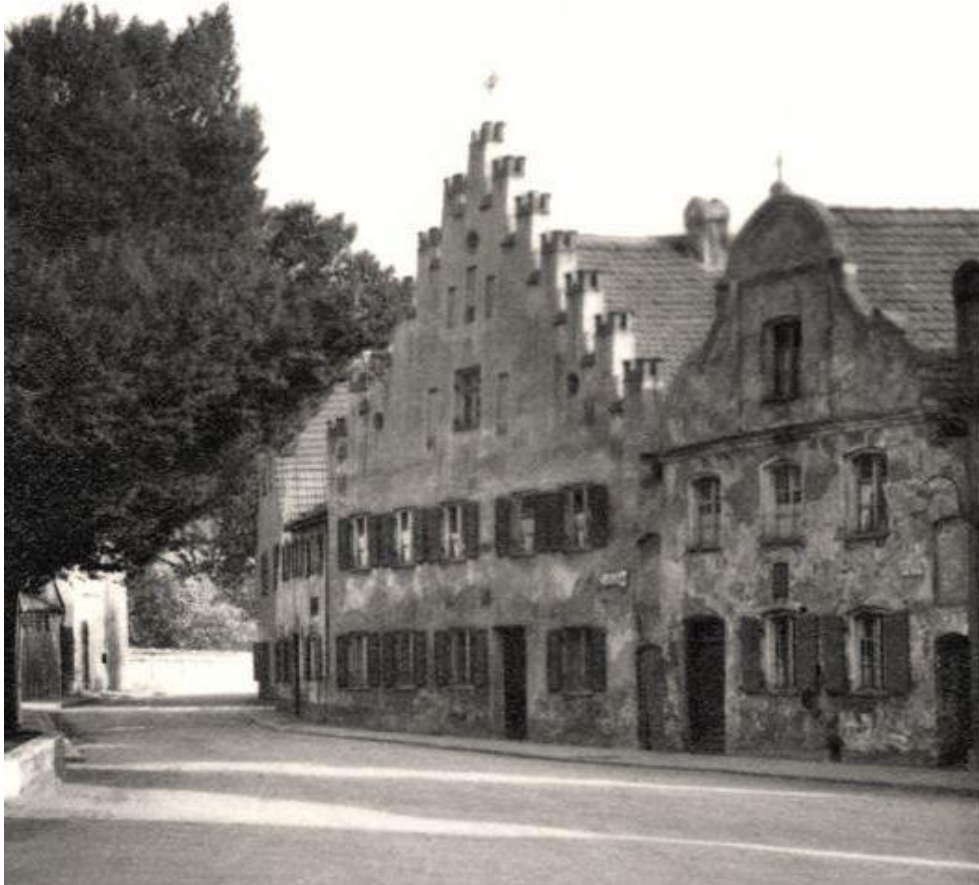
Aufnahme von 1948, stark angewitterte Fassade, die Formziegel der Zinnen sind naturbelassen. An den Fenstern sind im 1. OG und im EG Fensterläden vorhanden, im DG zugeklappt.
