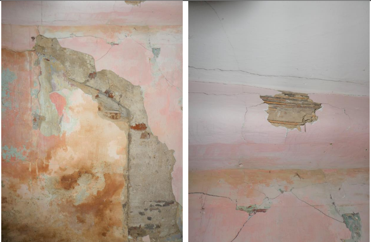
Nordzimmer im OG, zugemauerte Wandnische nach Nordwesten, Ziegelmauerwerk mit dünner Kalkschlämme und Kalkanstrichen. Streichbalken am Außenmauerwerk mit aufgenagelter Rohrmatte als Putzträger.
