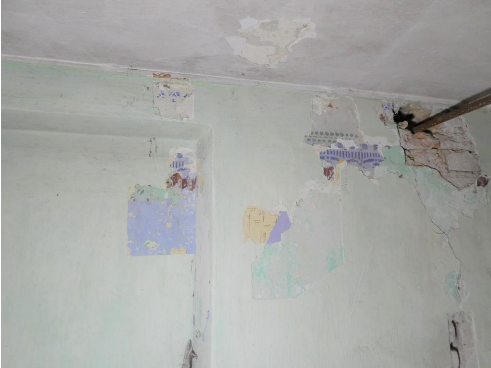
Südzimmer im 1. OG, diverse Schablonierungen und Farbfassungen an den Wandflächen aus dem 19. und 20. Jahrhundert.
